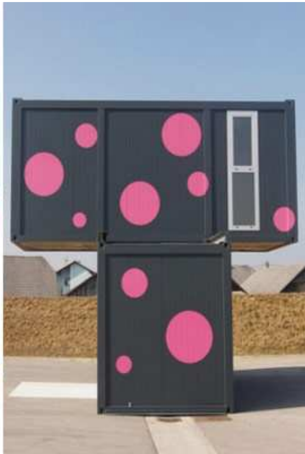
Architectes : Jure Kotnik Année 2007
